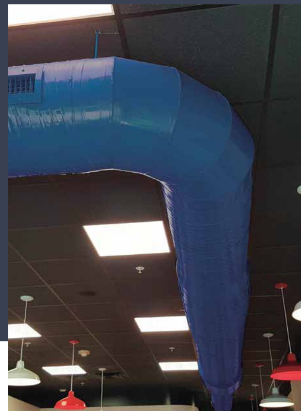
TRATAMIENTO QUÍMICO PARA LA APLICACIÓN DE PINTURA.
